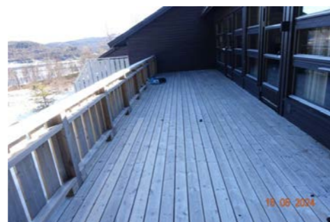
Terrasse ut fra stue.
