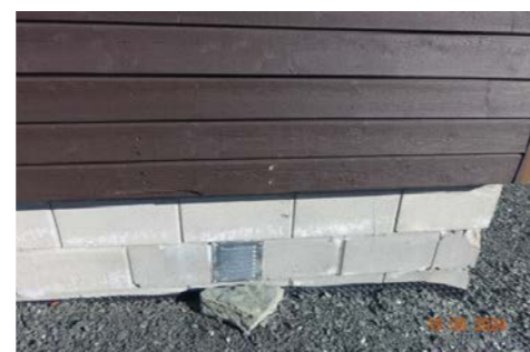
Drenert deler av grunnmur.
