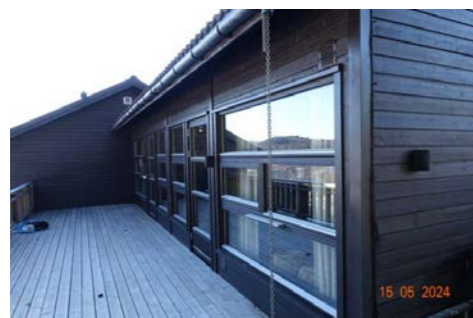
Vinduer av 2-lags glass
