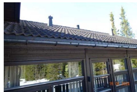
Tak tekket med takstein.
