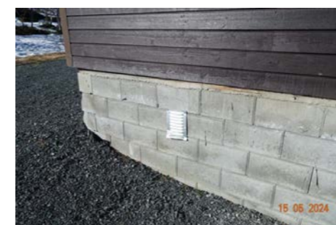
Grunnmur av systemblokker.
