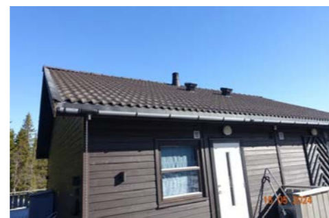
Tak tekket med takstein.
