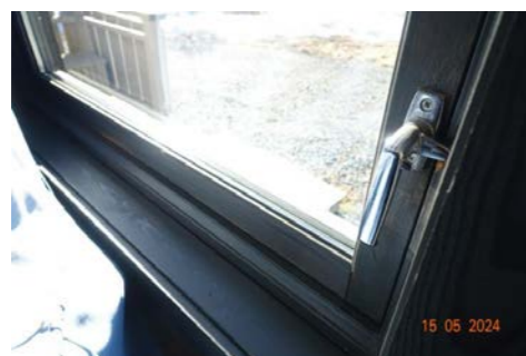
Vinduer av 2-lags glass
