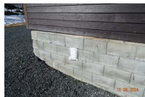
Drenert deler av grunnmur.
