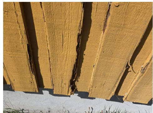
Synlig råte i fasadepanel
