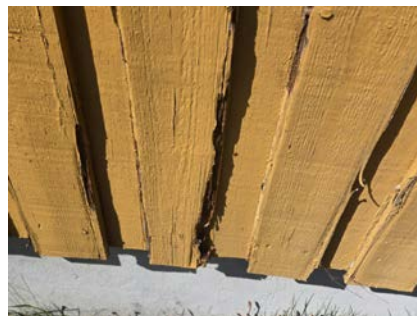
Synlig råte i fasadepanel
