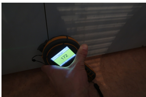
Fuktsøk i nedre del av våtromsplater
