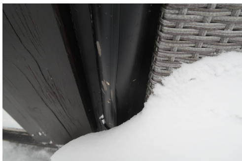
Frostsprengt nedløpsrør
