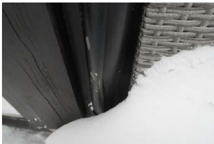
Frostsprengt nedløpsrør
