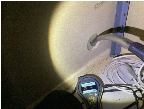
Viser fuktmåling i kjellerbod/nordøstlig hjørne uten å avdekke unormale verdier.
