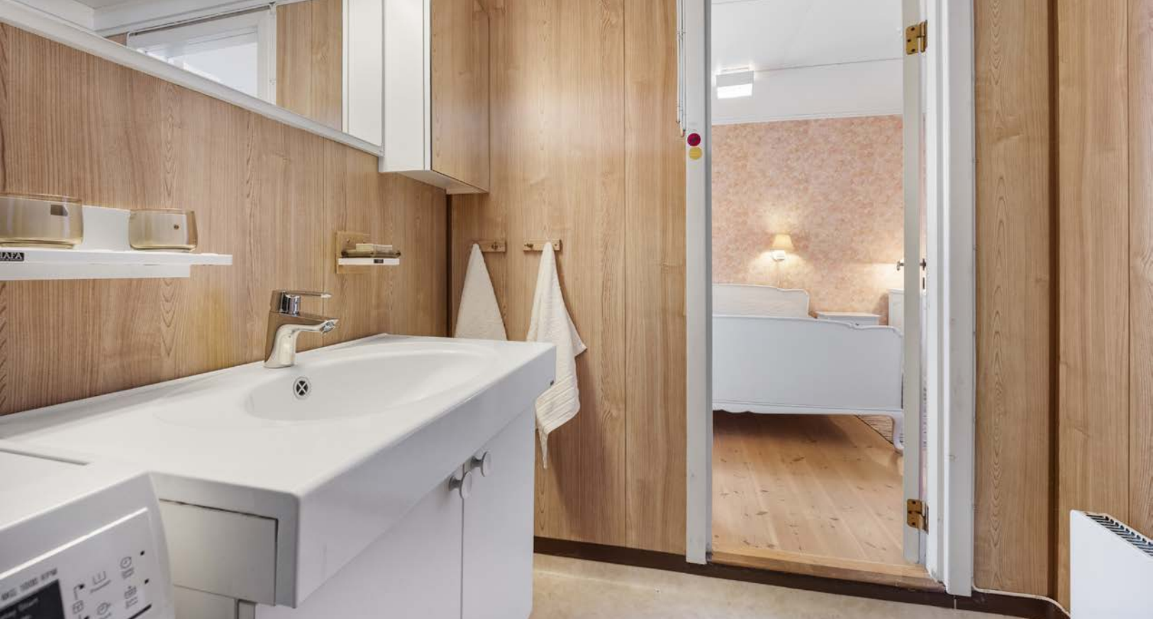
Badet har våtromsplater på veggene og lyst belegg på gulv med sluk.
