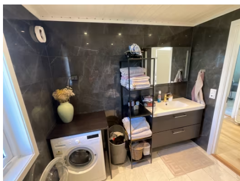
Viser baderomsinnredning og opplegg for vaskemaskin.
