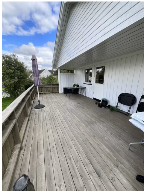
Viser delvis overbygget terrasse mot vest med adkomst fra stue og terreng.
