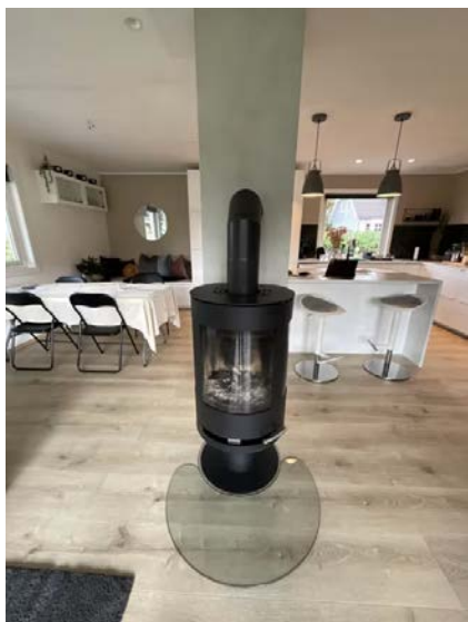
Viser ildsted montert i stue.
