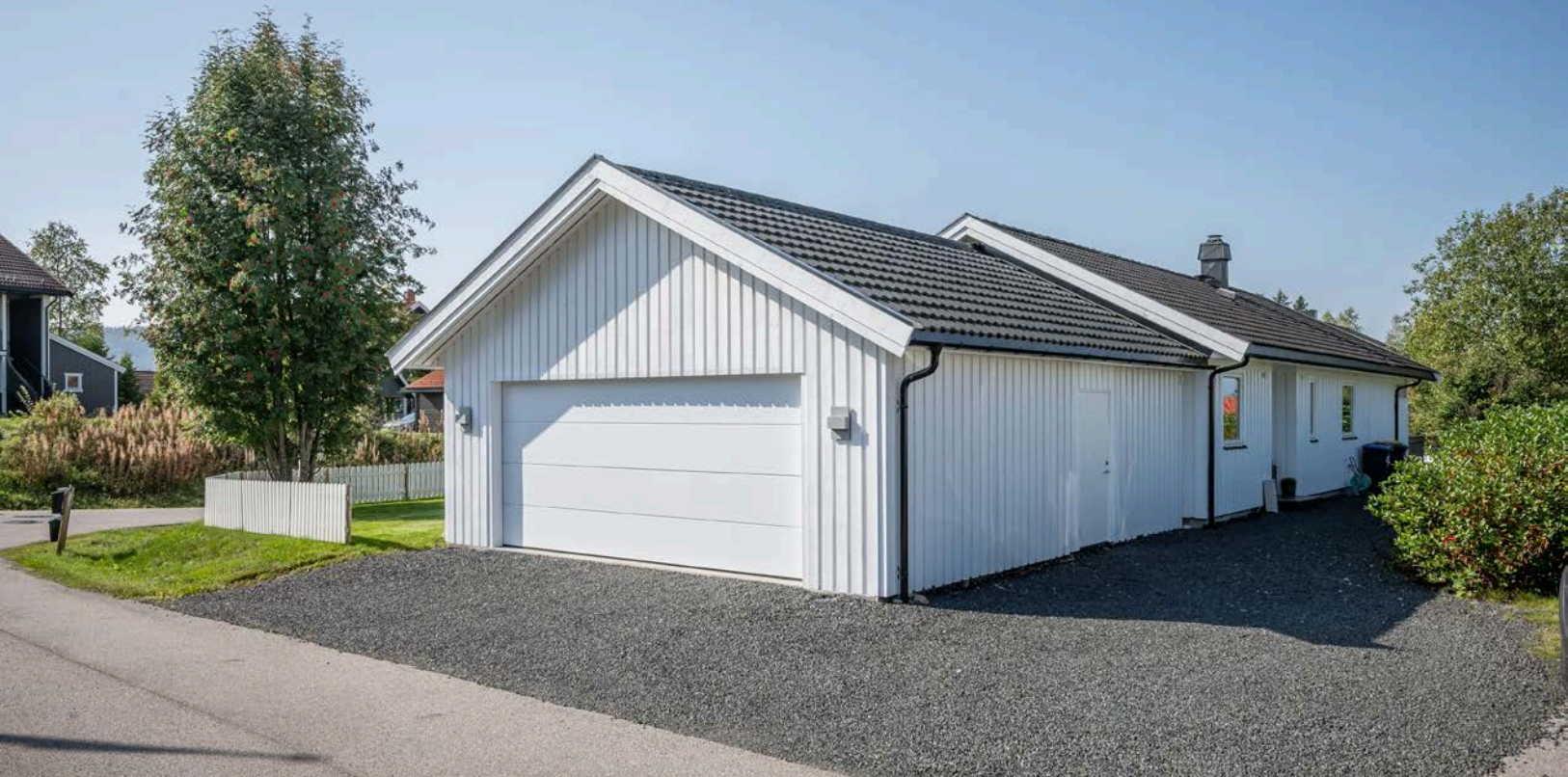
Inntilbygget dobbelgarasje ferdigstilt i 2019 med elbil-lader.
