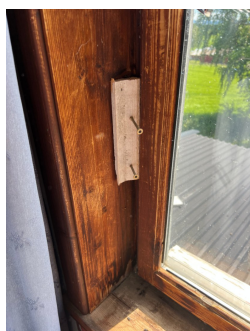
Gang 1. Etg: Punktert vindu, svertesopp og avflassing.
