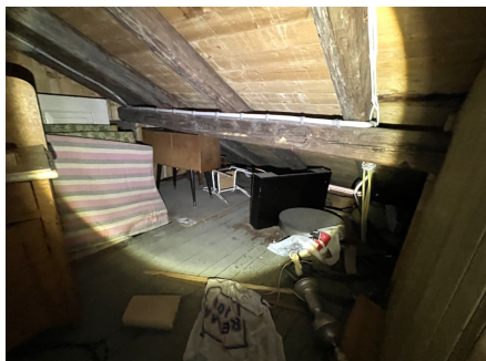
Bilde: Kott/loft 2. etg.
