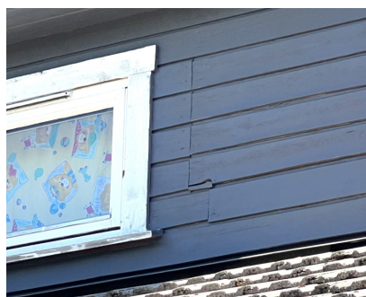
Takoppløft- Innskjøtede kledningsbord.
