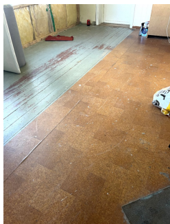
1. Etg: Stuegulv. Korkbelegg og malt tregulv.
