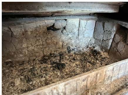
Peisovn 2. etg: Innvendig. Defekte ildfaste stein.
