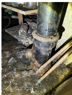
Soil hovedavløpsrør. Høyre for åpning til eldre kjeller.
