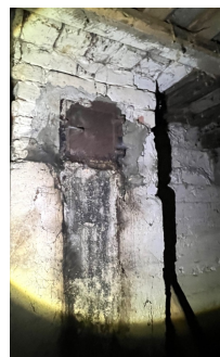
Peisovn 2. etg: Innvendig. Defekte ildfaste stein.
