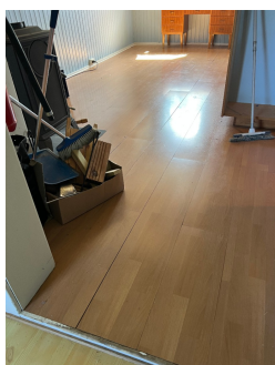
2. Etg: Kjøkkengulv. Nedskrudd laminatgulv.
