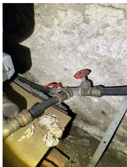
Vannrør og stoppekraner i kjeller.
