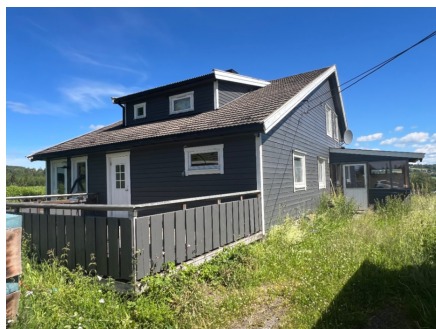
Fremside og gavlvegg sørside mot innglasset terrasse: Flatt.
