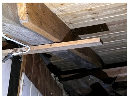
Bilde: Påmonteret bord på bjelker.
