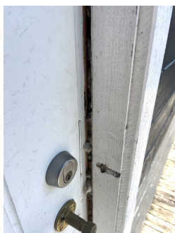
Utett mellom omramning og karm.
