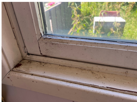
Gang 1. Etg: Punktert vindu, svertesopp og avflassing.
