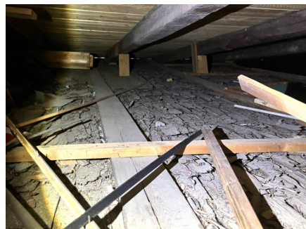
Bilde: Fra kott/loft 2. etg- mot mønet. Understøttinger.
