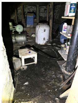
Eldre del av kjeller: Fritt vann/bløtt på bakken/gulvet.
