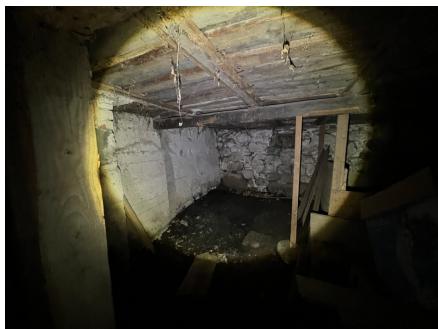
Eldre kjeller: Del av blindkjeller ligger bla. til venstre bak murvegg.
