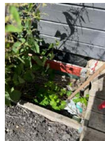
Utvendig ved innglasset terrasse: Åpning for kjellervindu el.
