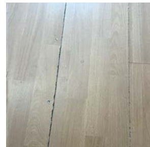
2. Etg: Kjøkken. Nedskrudd gulv.
