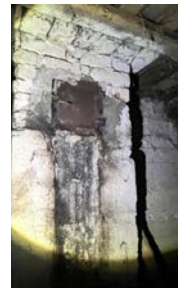
Peisovn 2. etg: Innvendig. Defekte ildfaste stein.
