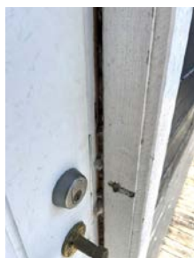
Utett mellom omramning og karm.
