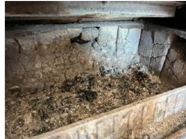
Peisovn 2. etg: Innvendig. Defekte ildfaste stein.
