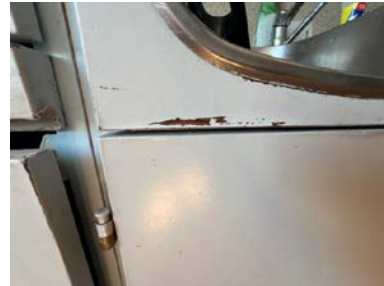
Skader/Merker i front.
