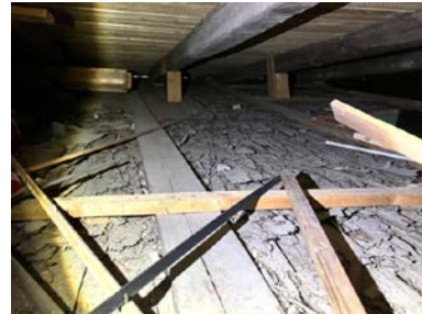
Bilde: Fra kott/loft 2. etg- mot mønet. Understøttinger.
