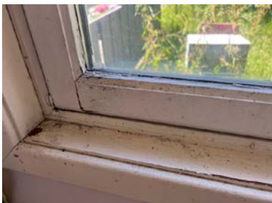
Gang 1. Etg: Punktert vindu, svertesopp og avflassing.
