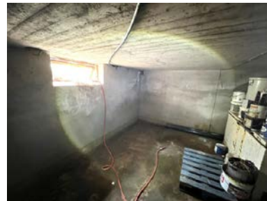
Nyere del av kjeller.
