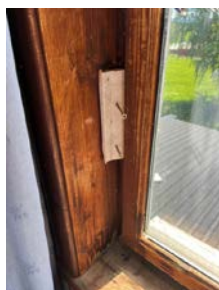
Gang 1. Etg: Punktert vindu, svertesopp og avflassing.
