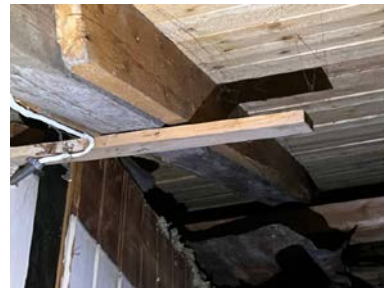
Bilde: Påmonteret bord på bjelker.
