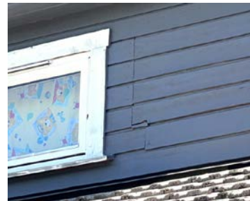
Takoppløft- Innskjøtede kledningsbord.
