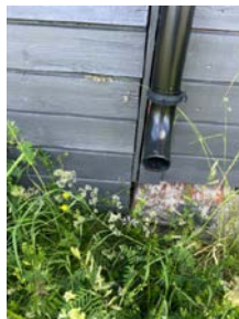
Løse isbord - fremside- høyre side. Spiker stikker opp.
