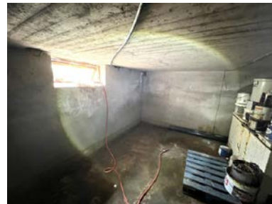
Nyere del av kjeller.
