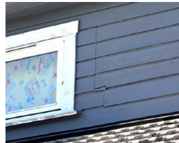
Takoppløft- Innskjøtede kledningsbord.
