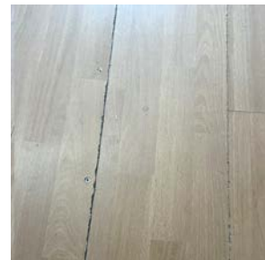
2. Etg: Kjøkken. Nedskrudd gulv.
