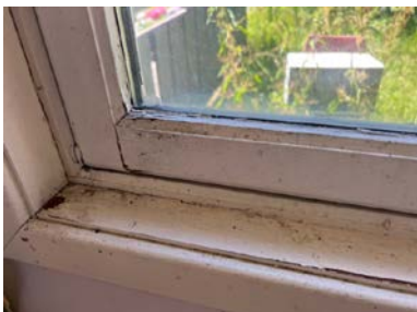
Gang 1. Etg: Punktert vindu, svertesopp og avflassing.
