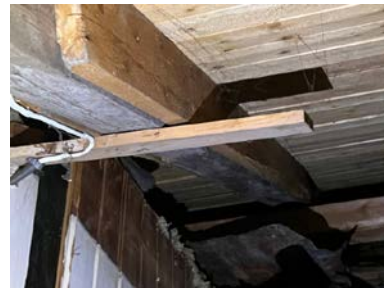
Bilde: Påmonteret bord på bjelker.
