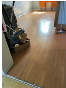
2. Etg: Kjøkkengulv. Nedskrudd laminatgulv.
