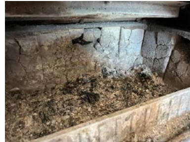
Peisovn 2. etg: Innvendig. Defekte ildfaste stein.
