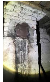
Peisovn 2. etg: Innvendig. Defekte ildfaste stein.
