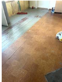
1. Etg: Stuegulv. Korkbelegg og malt tregulv.
