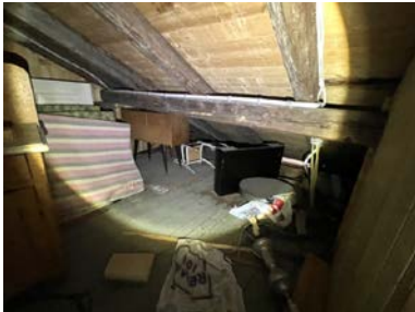
Bilde: Kott/loft 2. etg.
