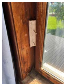
Gang 1. Etg: Punktert vindu, svertesopp og avflassing.
