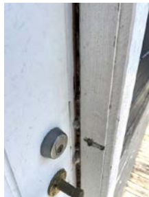
Utett mellom omramning og karm.
