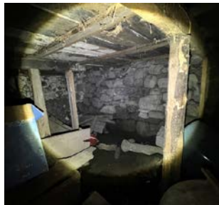
Eldre del av kjeller: Fritt vann/bløtt på bakken/gulvet.
