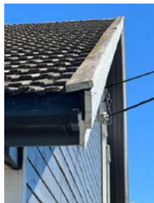
Løse isbord - fremside- høyre side. Spiker stikker opp.
