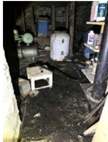
Eldre del av kjeller: Fritt vann/bløtt på bakken/gulvet.
