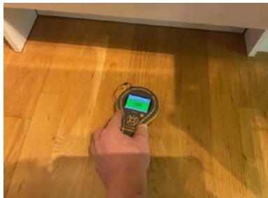
Med enkle fuktsøk ble det ikke registrert unormale verdier.
