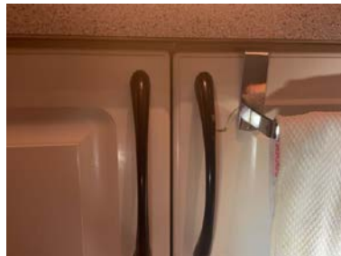
Hakk/sår på skapdør.
