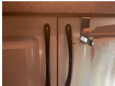
Hakk/sår på skapdør.
