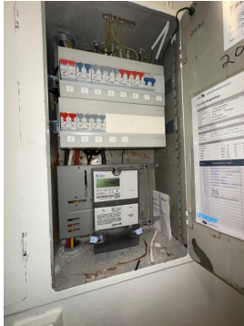
Sikringsskap med automatsikringer.
