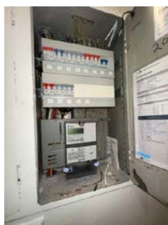
Sikringskap med automatsikringer.
