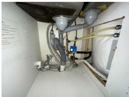
Røropplegg i kjøkkenbenk med Waterguard
