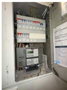
Sikringskap med automatsikringer.
