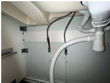
Røropplegg under vask på bad i underetasje
