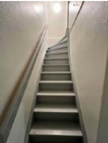
Trapp mellom underetasje og 1. etasje
