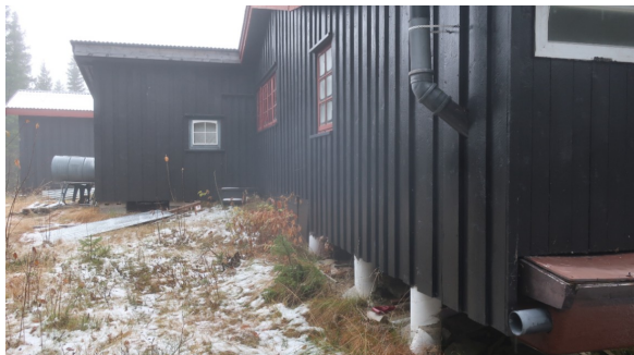
Punktfundament under tilbygg.
