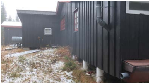
Punktfundament under tilbygg.
