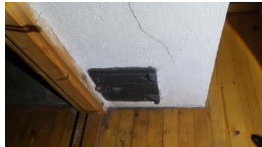
Feieluke for nær treverk. Mangler plate på gulv under luken.
