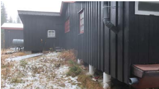
Punktfundament under tilbygg.
