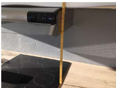
Lav høyde på avtrekksvifte (43 cm).
