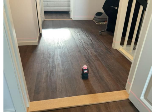
Måling av planavvik på loft.
