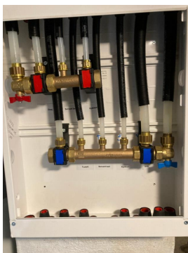
Fordelerskap for rør i rør, montert i kjeller
