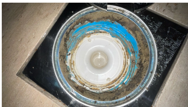
Bilde viser sluk under tidligere dusjkabinett.
