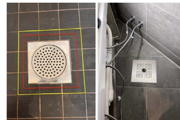
Planlagt åpning rundt sluk.
