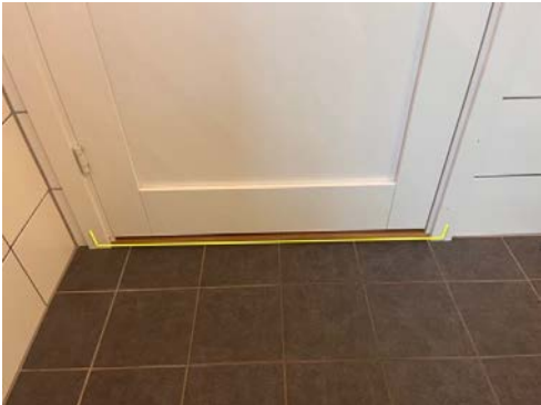
Planlagt utbedring ved terskel.
