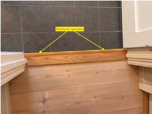
Planlagt utbedring ved terskel.
