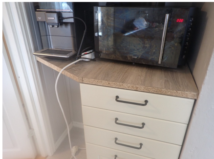
Ingen folie i endevend på benkeplate / dårlig innfesting.
