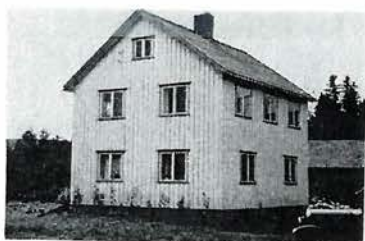
Bruheim , gnr. 50, bnr. 34, ligger like ved Bjøra bru, mellom Overhalla og Skogmo. Postadr. Skogmo. Areal 1,1 da. Våningshus oppf. 1952 av bindv. i 2 etsj., 56 m 2 , 7 rom, kjøk., ver., kjeller, bad. Vedskjul. Branntakst 35 000. — Eier anleggsarb. Nidar Lysberg, f. 13/2—20 i Overhalla, foreldre Inga og Olaf L.
