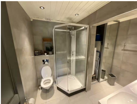
Viser innebygget sistene, dusjkabinett, plassering av vvb og vaskemaskin.
