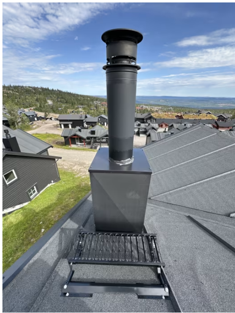
Viser feieplattform og beslag.
