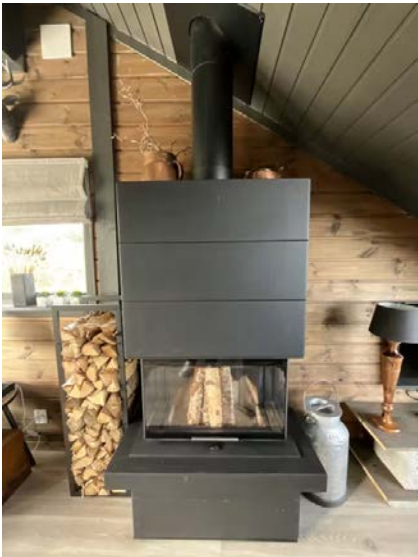
Viser ildsted montert i stue.
