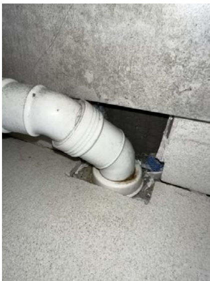
Det er ikke synlige mansjetter / tettesjikt ved rørgjennomføringer i gulv.
