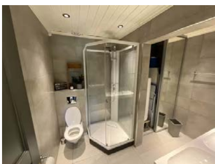
Viser innebygget sistene, dusjkabinett, plassering av vvb og vaskemaskin.
