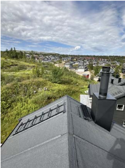
Viser fastmontert stige, feieplattform og pipebeslag.
