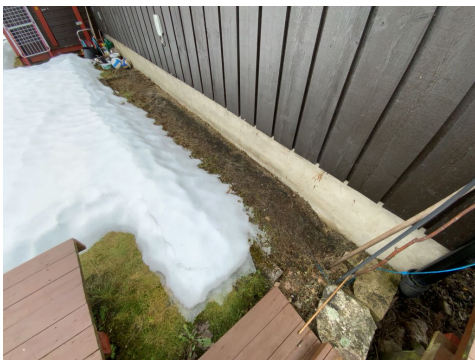
Kontroll av drenering/fuktsikring.
