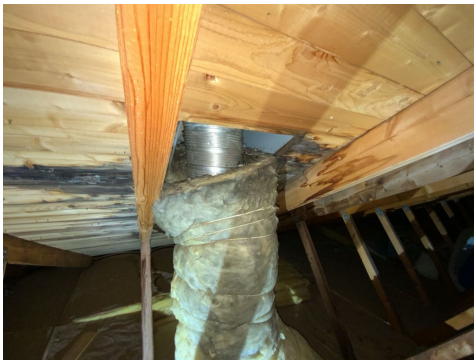
Kontroll rundt rørgjennomføringer.
