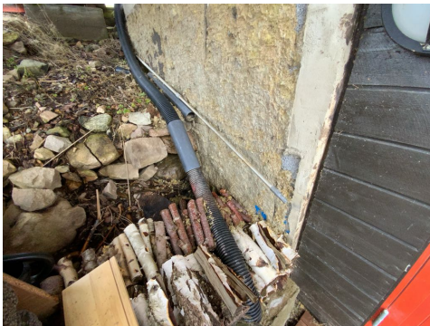
Kontroll av drenering/fuktsikring.
