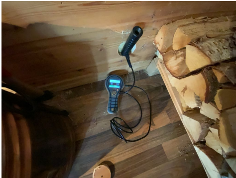
Utført hulltaking på rom under terreng.
