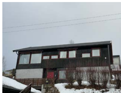
Besiktigelse av taktekke.
