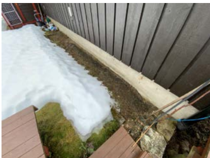
Kontroll av drenering/fuktsikring.
