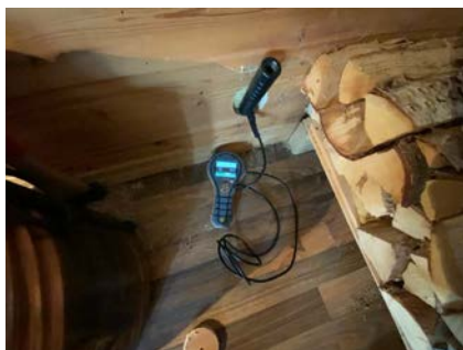
Utført hulltaking på rom under terreng.
