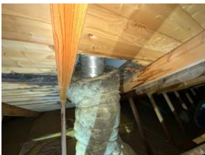
Kontroll rundt rørgjennomføringer.
