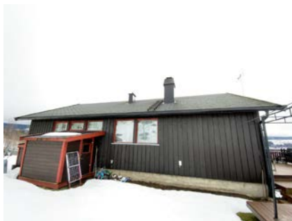
Besiktigelse av taktekke.
