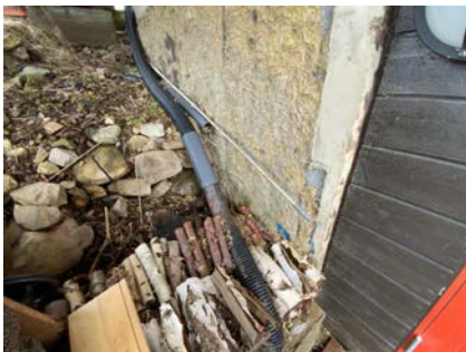
Kontroll av drenering/fuktsikring.
