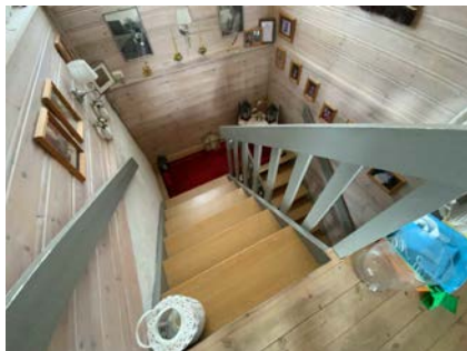
Besiktigelse av trapp.
