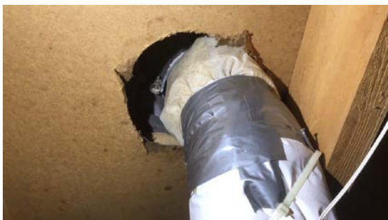
Utettheter rundt gjennomføringer
