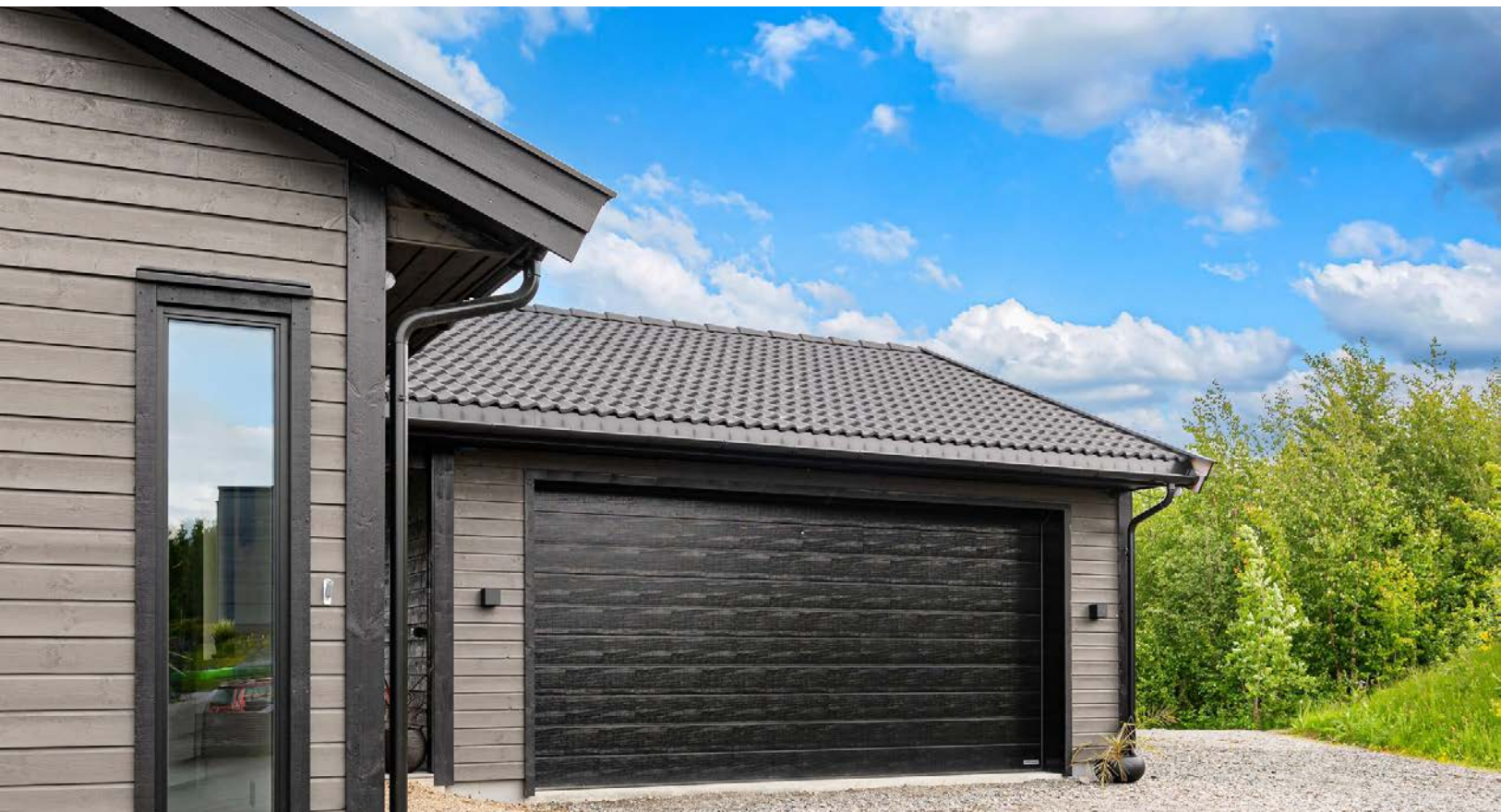
Garasje på eiendommen.
