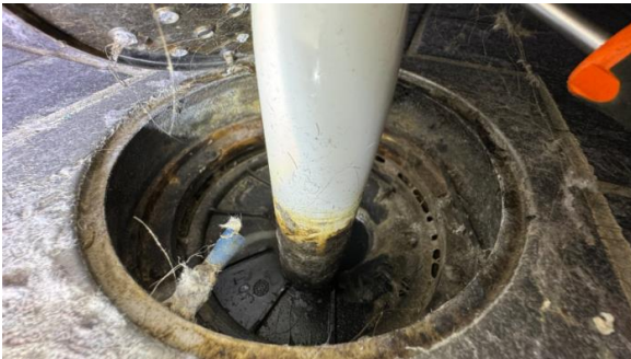
Kontroll av sluk.
