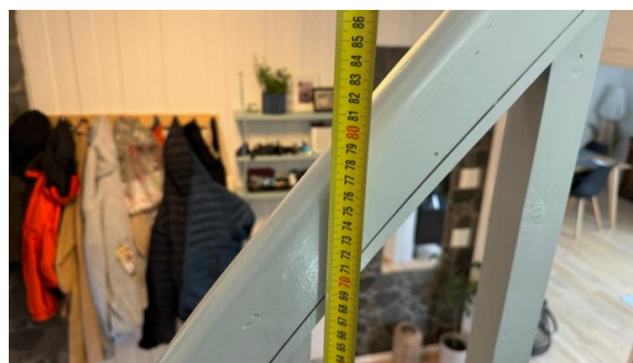
Kontroll av rekkverkshøyde.
