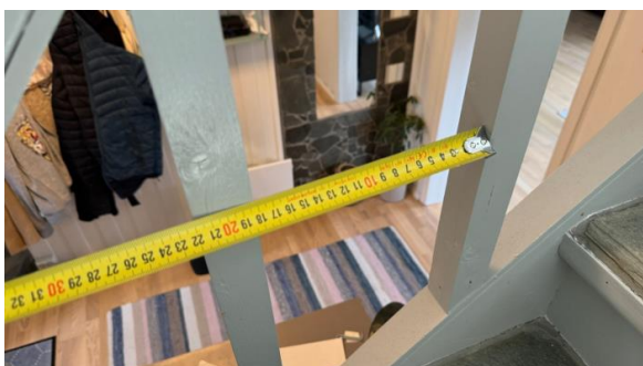
Kontroll av åpninger i rekkverk.
