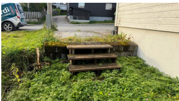
Liten forstøtningsmur mellom parkering og hage.
