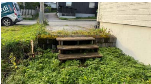
Liten forstøtningsmur mellom parkering og hage.
