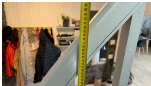
Kontroll av rekkverkshøyde.
