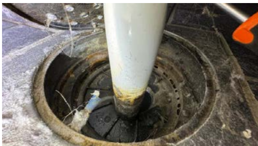
Kontroll av sluk.
