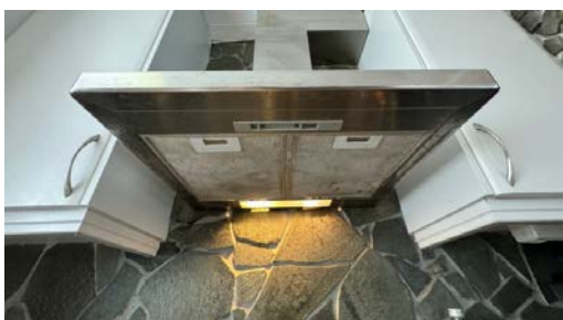
Kontroll av avtrekk.
