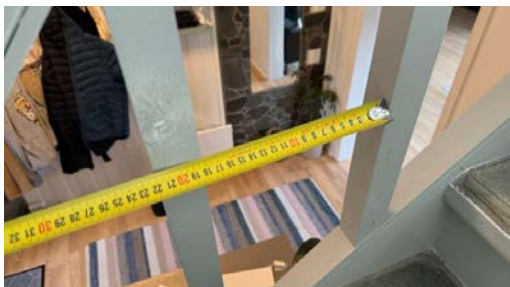
Kontroll av åpninger i rekkverk.
