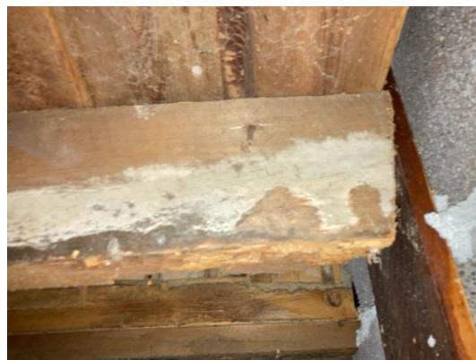
Råteskadet bjelke.
