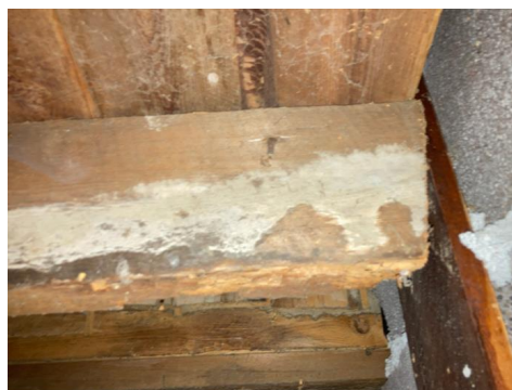
Råteskadet bjelke.
