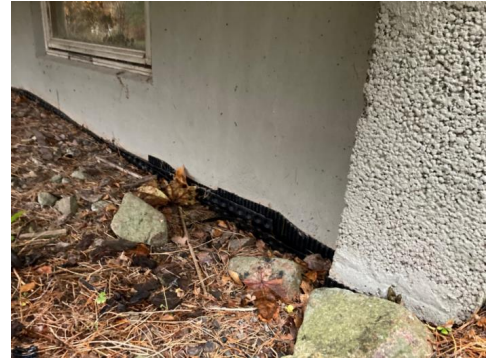
Synlig fuktsikring mot sør.
