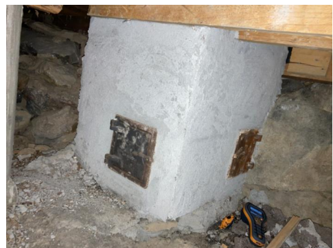
Sotlucker i kjellerrom under tv-stue.
