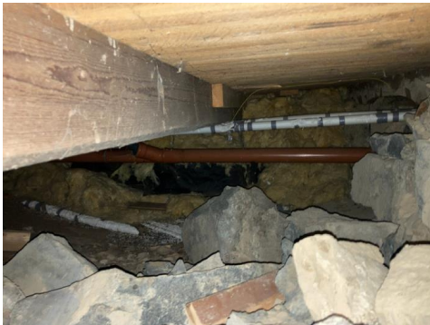
Uisolert bjelkelag i krypkjeller.
