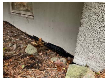
Synlig fuksikring mot sør.
