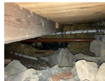
Uisolert bjelkelag i krypkjeller.
