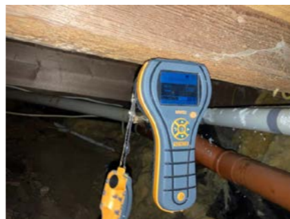
Ved bruk av fuktindikator ble det målt normale verdier i tilgjengelig trevirke.
