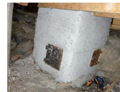
Sotlucker i kjellerrom under tv-stue.
