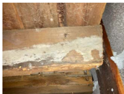
Råteskadet bjelke.
