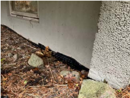
Synlig fuksikring mot sør.
