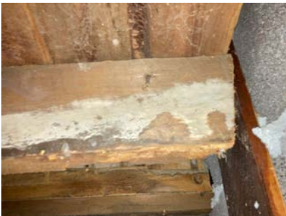
Råteskadet bjelke.
