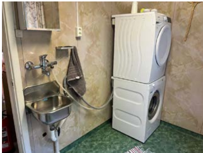
Vaskerom i 1.etasje.
