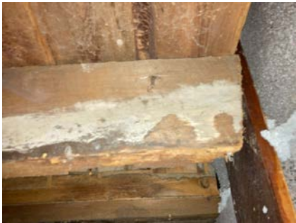
Råteskadet bjelke.
