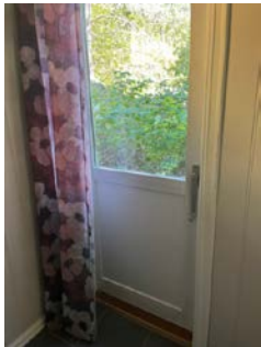
Eldre dør med noe slitasje, opprettholder sin funksjon.
