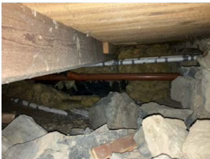
Uisolert bjelkelag i krypkjeller.
