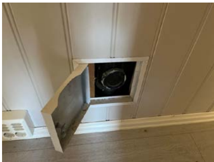
Stakeluke for avløp i 1.etasje mot bad.
