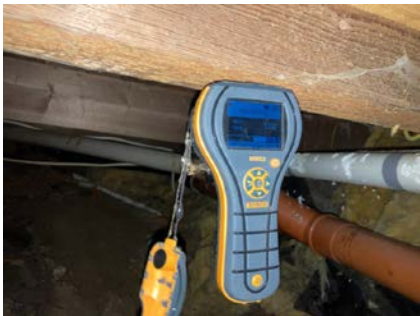
Råteskadet bjelke.
