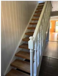
Trapp til loftetasje blir vurdert etter dagens krav.
