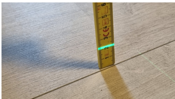
Kontroll av planavvik.
