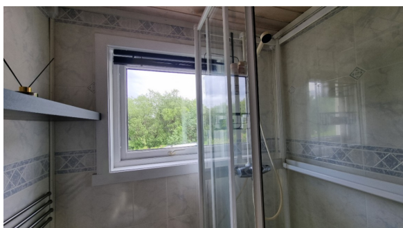
Det er vindu i våtsonen.
