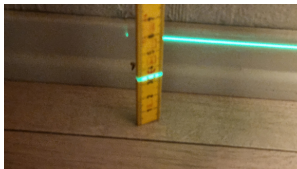
Kontroll av planavvik.
