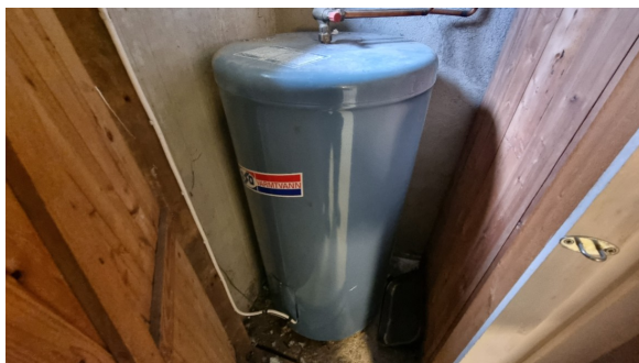
Varmtvannsbereder fra 1985.
