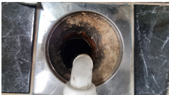
Kontroll av sluk.
