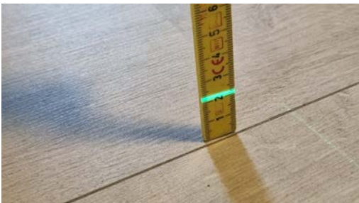
Kontroll av planavvik.
