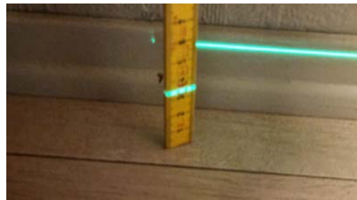
Kontroll av planavvik.
