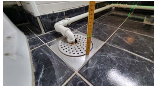
Kontroll av fall.
