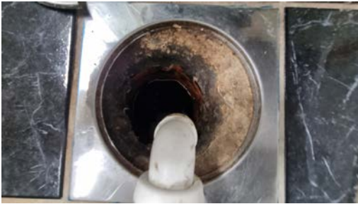
Kontroll av sluk.
