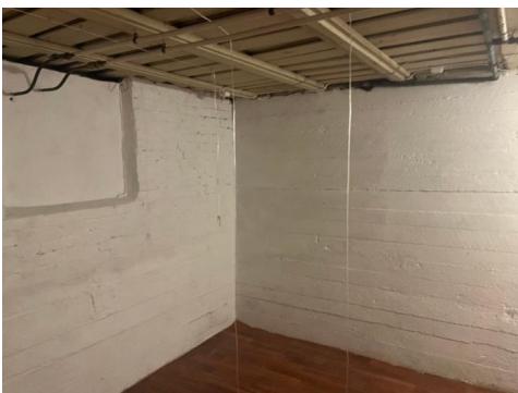
Kjellerrom under kjøkken med gjenmurt vindu.
