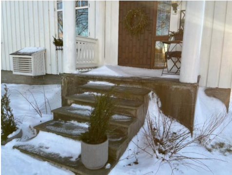
Trapp til veranda.
