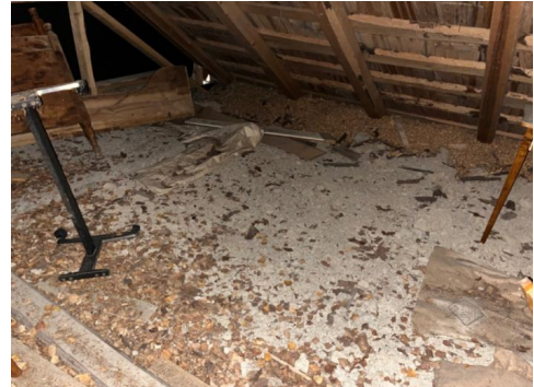
Etasjeskille isolert med bl.a. leire og sagflis.
