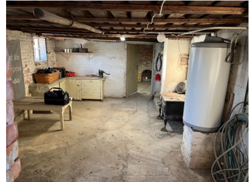
Kjeller med utvendig tilgang.
