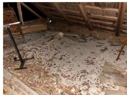
Etasjeskille isolert med bl.a. leire og sagflis.
