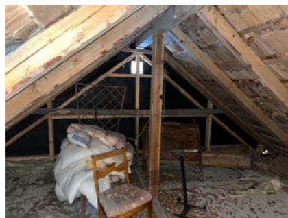
Møneloft med "nyere" gavlvegg.
