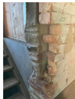
Støpt grunnmur forblendet med teglstein.
