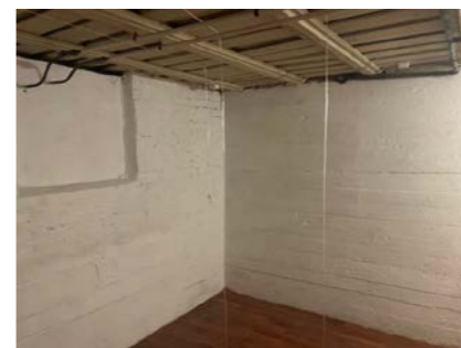
Kjellerrom under kjøkken med gjenmurt vindu.
