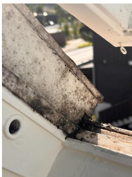
Punktert glass og sprekk i takvindu.
