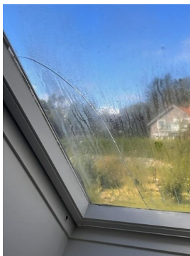
Punktert glass og sprekk i takvindu.
