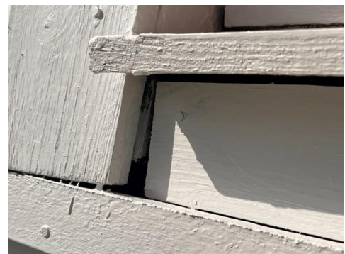
Ikke fagmessige utført under vindu i 2 etg. og med risiko for inndrev av vann.
