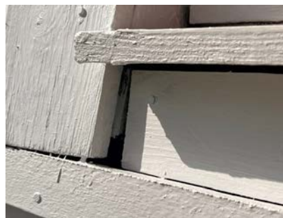
Ikke fagmessige utført under vindu i 2 etg. og med risiko for inndrev av vann.
