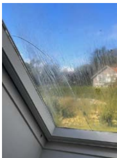
Punktert glass og sprekk i takvindu.
