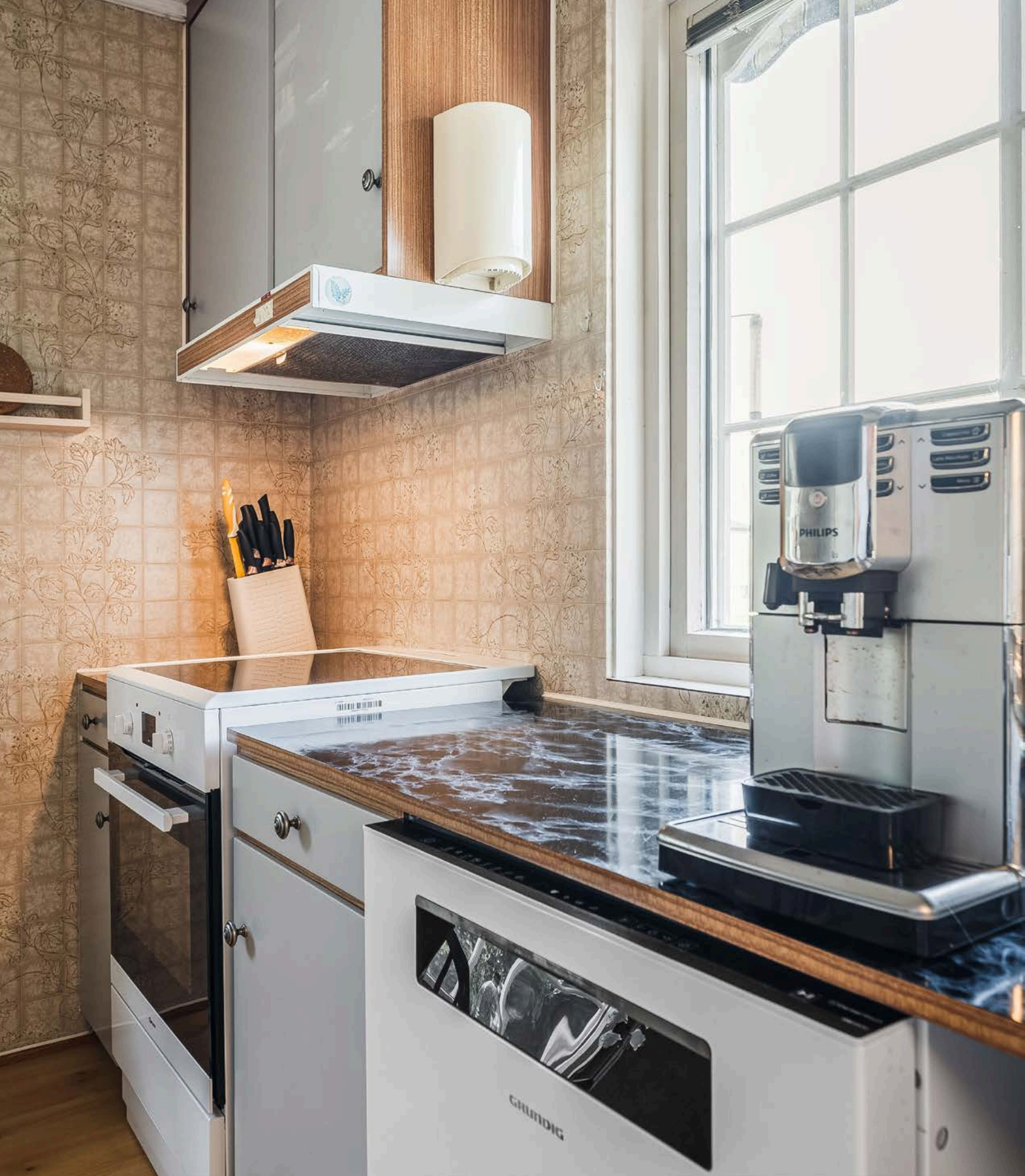
Det er ventilator over komfyrplass med avkast via yttervegg.
